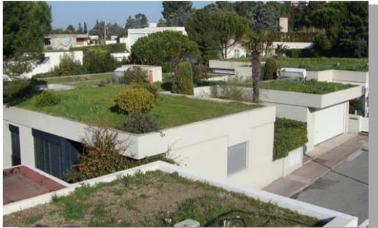
1) une toiture végétalisée permet de faire baisser le coefficient d'imperméabilisation à 0,4 / 0,6
